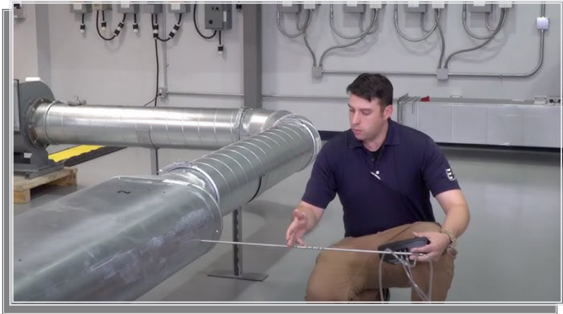
▲ استفاده از لوله پیتو
