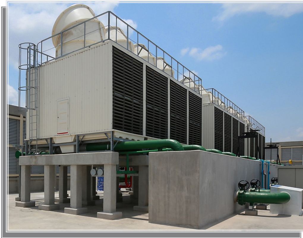
▲ یک برج خنک کن مونتاژ شده در کارخانه غالباً برای سرمایه‌اش آسیابی یا سیستم‌های فرآیندی کوچک مورد استفاده قرار می‌گیرد.
